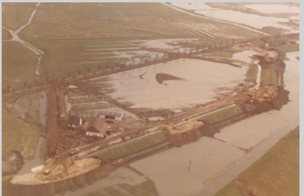
11. Januar sind die Deichbruchstellen mit Sand verfüllt
